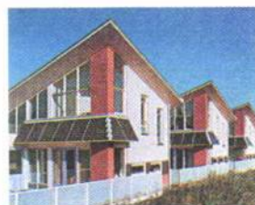
Рис. 279. Фотоэлектрические установки на домах
